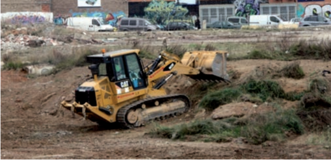
Màquina treballant a la zona del Gorg on hi ha projectat el canal
