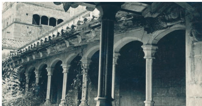
La galeria del primer pis, amb els arcs escarsers i una gàrgola amb la figura d'un lleó.
