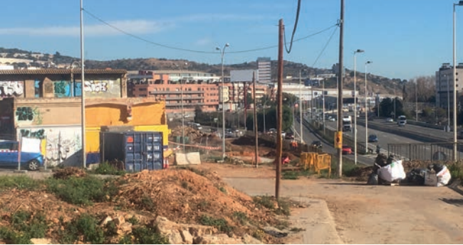
Els treballs per construir el lateral ja han començat
