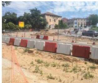
Imatge de les obres aturades al barri de Bufalà
