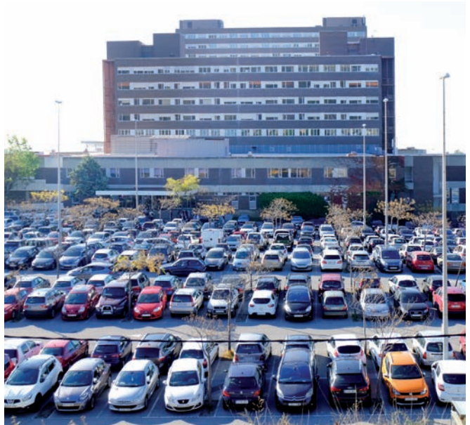
Imatge realitzada, aquest dimecres, a l'aparcament de l'Hospital de Can Ruti
