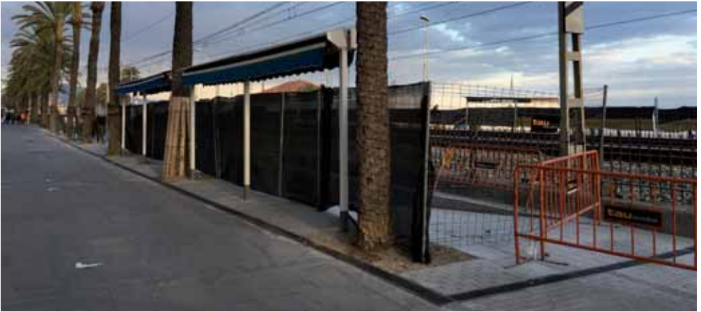
Les obres, del pas, estan aturades des de fa dies
