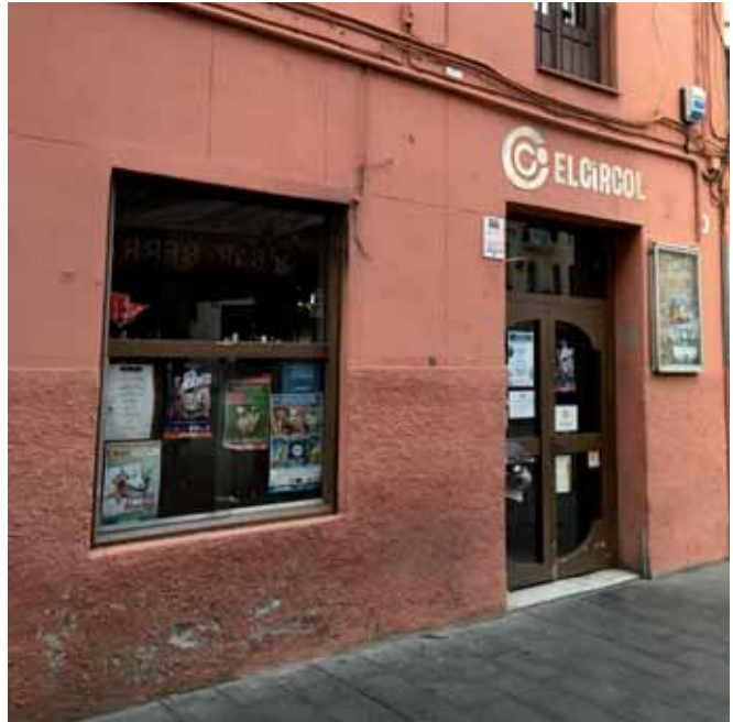
Imatge de l'edifici del Círcol, al Centre de Badalona
