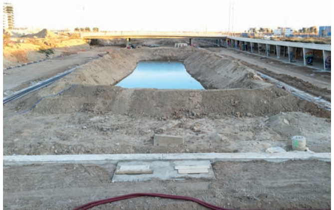
Imatge de les obres al canal del Gorg, amb aigua acumulada, fa uns dies
