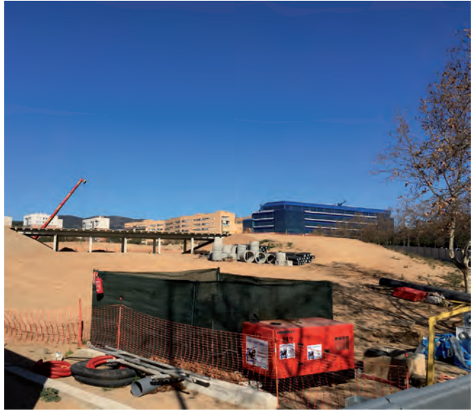
Imatge de les obres al nou estadi de futbol a Montigalà
