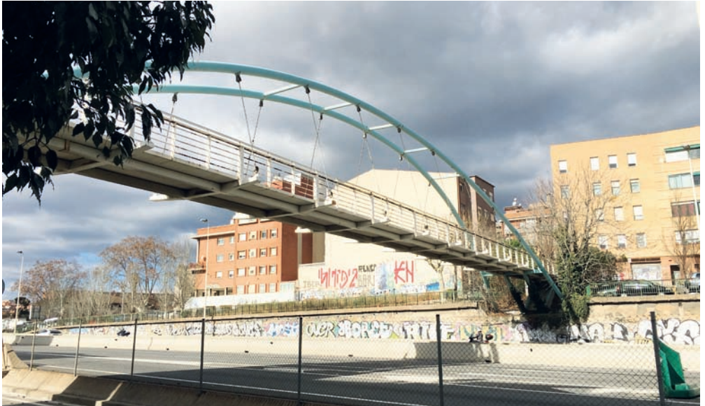
Imatge del pont al carrer d'en Felip i d'en Rosés
