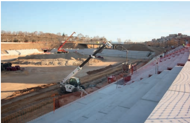
Imatge de les obres del nou estadi del Badalona a Montigalà
