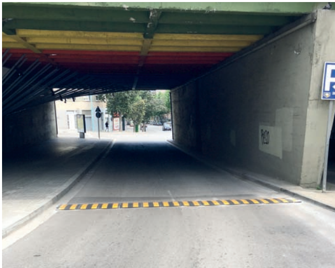
Imatge de la banda rugosa que s'ha instal·lat a Bufalà
