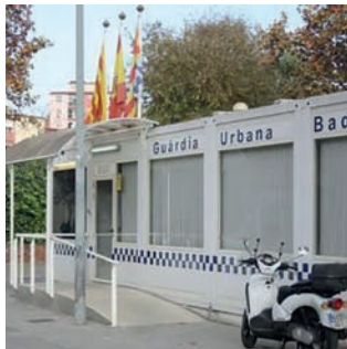
Imatge exterior del mòdul policial de Sant Roc
