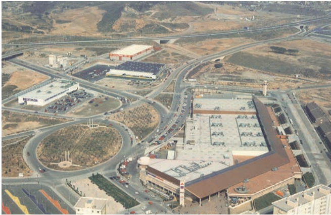
Imatge del Centre Comercial Montigalà, ara fa 25 anys
