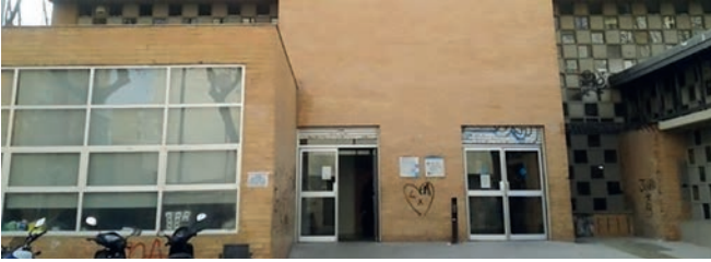
Imatge exterior de l'ambulatori de Sant Roc
