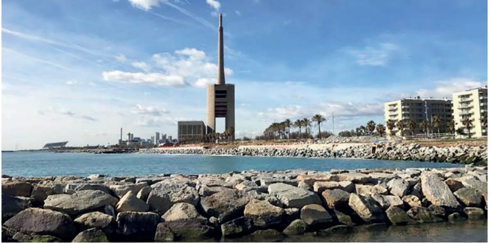
Imatge de les obres a la platja de la Mora
