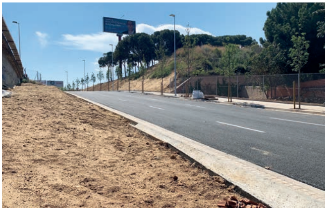
Imatge del tram del lateral a l'altura de Bufalà
