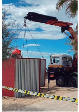
Instal·lació dels mòduls a les platges
