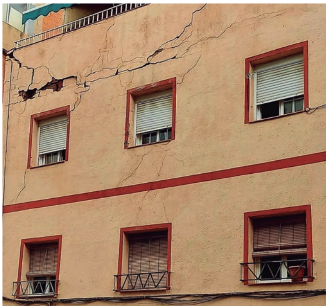
Imatge de l'esquerra a l'edifici del carrer Granada
